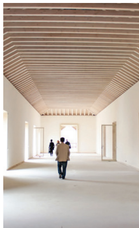
Après l'intervention de Carmo® Wood
