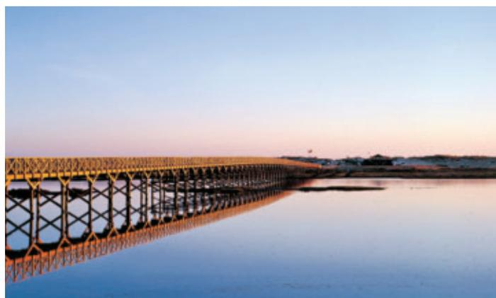
Les piles ont été ainsi enfoncées dans le sol ferme sous la boue à plus de 6 mètres de profondeur.
