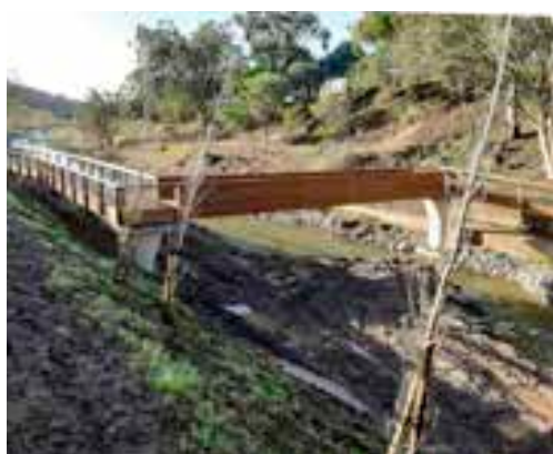
PONTE NO JAMOR
