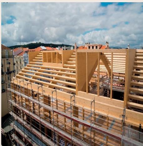
O **CLT** É UM PRODUTO ALTAMENTE TÉCNICO, DERIVADO DA MADEIRA, EM QUE PEQUENAS LAMELAS DE MADEIRA ESTRUTURAL SÃO COLADAS PERPENDICULARMENTE DE FORMA A CRIAREM PAINÉIS AUTOPORTANTES
