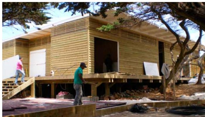
A Carmo – Estruturas em Madeira executou em 2013 a estrutura de apoio à Escola de Windsurf na Praia do Abano no Guincho com aproximadamente 270m<sup>2</sup> de implantação. A estrutura é toda em madeira maciça de pinho tratada em autoclave, tendo sido só em elementos estruturais pontuais usado madeira lamelada colada, por exemplo nas vigas de cobertura.
