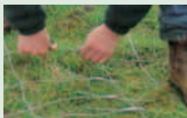
2 – No início da vedação retire da rede um número de arames verticais suficiente para enrolar em volta do poste terminal e enfiar de novo no 2º canal do gripple. Os arames verticais são fáceis de remover com a ajuda do alicate grippler.
