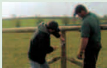
4 – Com o alicate grippler estique a rede na zona da união efectuada com o gripple. Ao fazê-lo deve esticar em ambos os sentidos.
