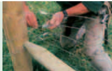
3 – Levante a rede, encoste-a aos postes e coloque-a na posição correcta. Grampeie a rede a um postes de escora.
