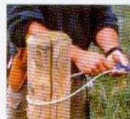
2. Passe o monofilamento à volta do poste terminal e pelo segundo canal do TENSULATOR.
