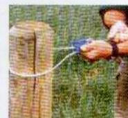
3. Coloque o arame a electrificar no canal próprio do TENSULATOR.
