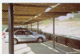
Estacionamento e Sustentação de Terras Praia Pego-Grândola
