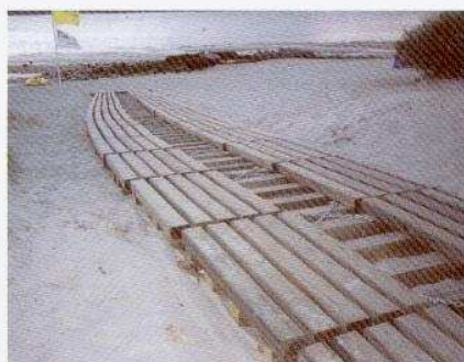
Passadiço para Passagem do Tractor do Lixo-Tróia
