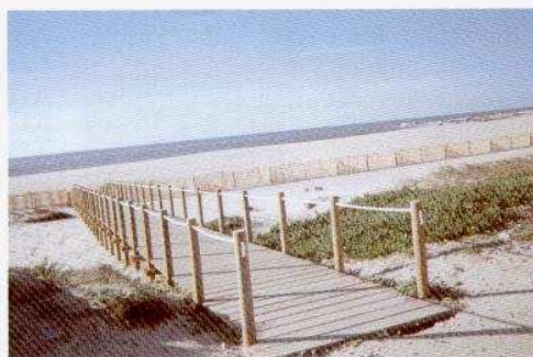
Passadiço e Regeneradores Dunares Praia Pedras Amarelas-V.N.Gaia
