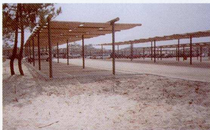
Estacionamento Praia da Comporta-Grândola
