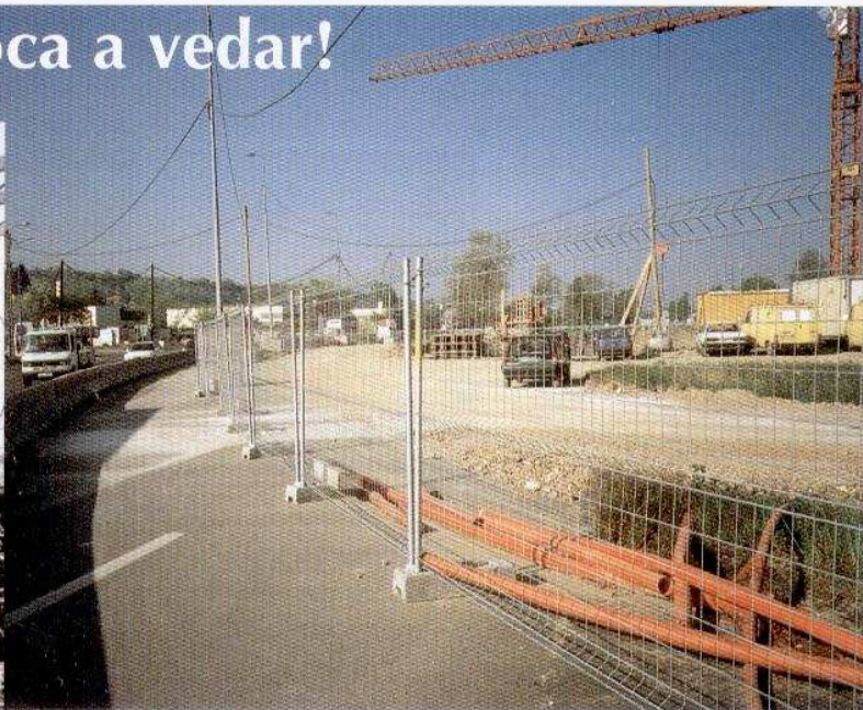
Vedando um Estaleiro
